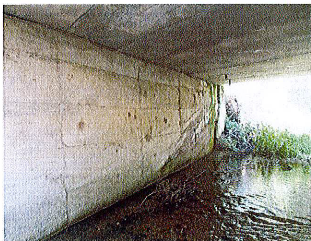
3. Degradări la nivelul elevației culeei mal drept.
