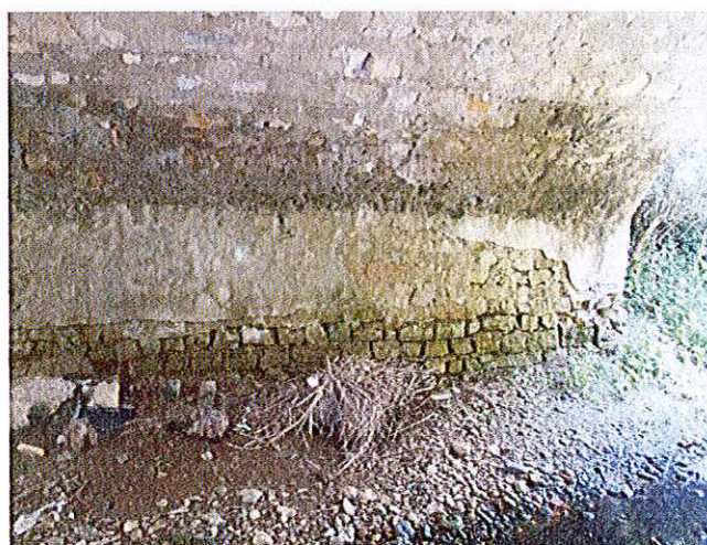
6. Degradări la nivelul fundațiilor.
