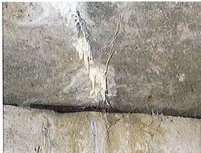
4. Degradări la nivelul intradosului (infiltrații și carbonatări).
