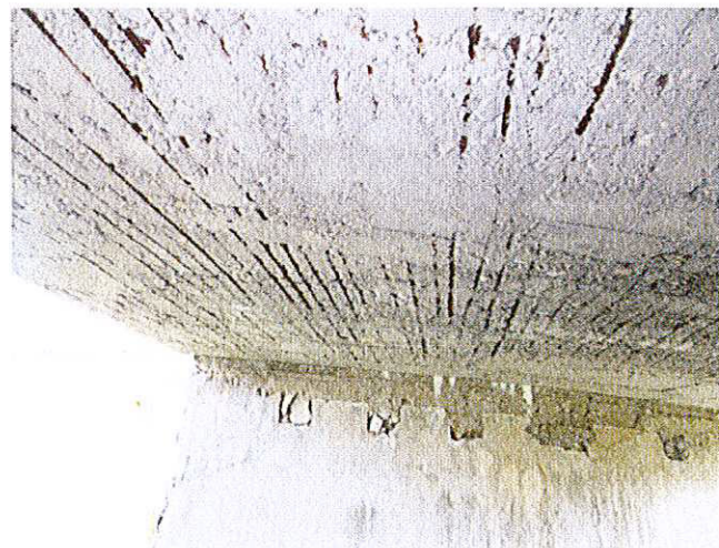
3. Culee mal stâng și armături fără acoperire la nivelul intradosului.
