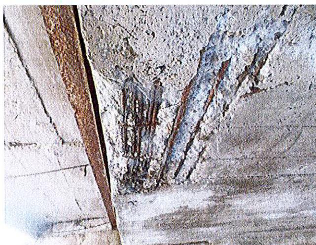
6. Armături fără acoperire la intrados
