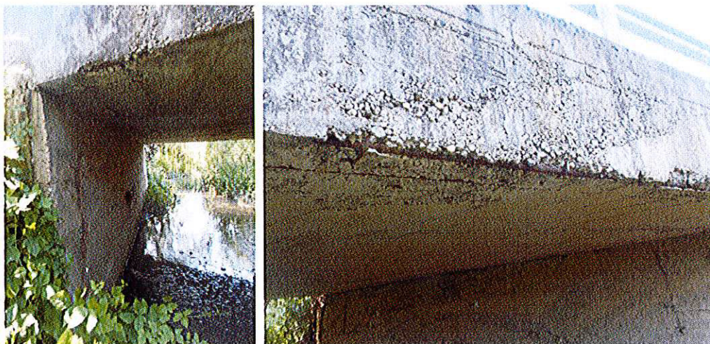
4. Degradări la nivelul dalei .
