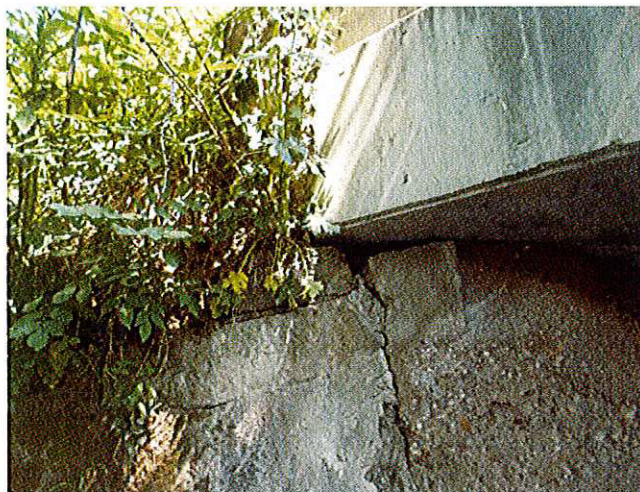
4. Rezemare necorespunzătoare a grinzii marginale și degradări la culee și aripă mal stâng amonte
