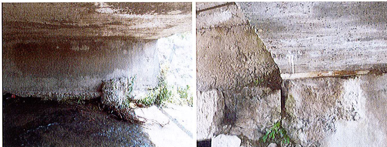
4. Infiltrații și carbonatări la nivelul intradosului podului.
