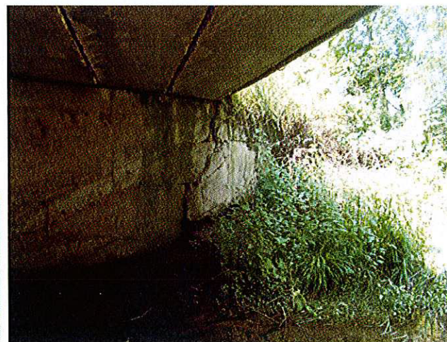
3. Degradări la nivelul elevației culeei mal drept.
