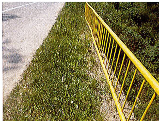
5. Coronament pod și prezența vegetației pe suprastructură.
