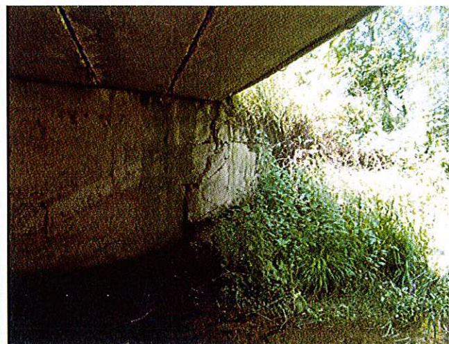
3. Degradări la nivelul elevației culeei mal drept.
