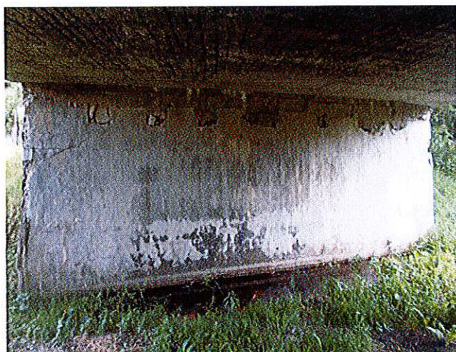
3. Culee mal stâng și armături fără acoperire la nivelul intradosului.
