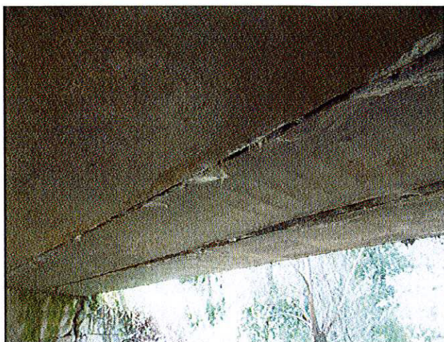
4. Degradări la nivelul intradosului (infiltrații și carbonatări).
