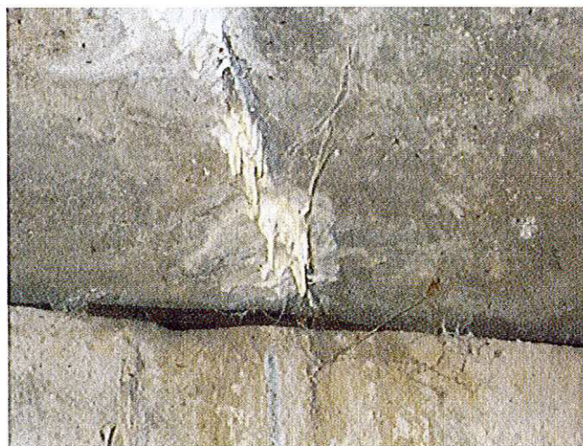
4. Degradări la nivelul intradosului (infiltrații și carbonatări).
